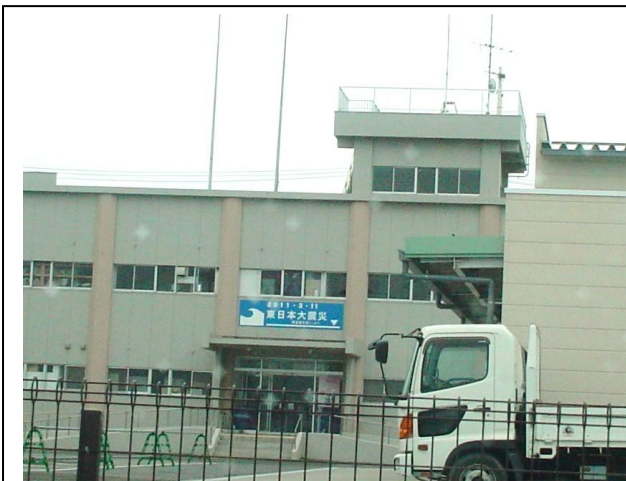
【海岸近くの工場に掲げてあった標識・玄関の上の青色標識の下部白横線まで浸水した】
