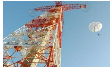
<写真① 陸自習志野駐屯地の落下傘降下塔> 50mの高度から降下させ、降下中の姿勢、落下傘の操縦、着地動作の訓練等、航空機降下の前の地上での訓練の集大成としての訓練設備と言われる。
