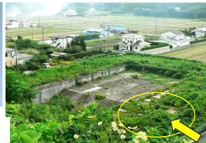
<写真② 館砲校・飛行特技員訓練プール跡、佐野> 矢印の一角に鉄塔の土台として用いられたと思われる十数個のコンクリ・ブロック(1m立法)が残されている。鉄塔は高さ十数mと考えられ、陸自の降下塔と異なり「水面上4~5mの感覚」を身体で覚えさせることを目的としたものであろう。
