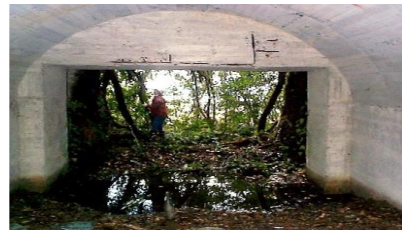
<香(こうやつ)砲台跡(壕内)> 市内8カ所の砲台のうち、香・浜田砲台は州ノ空が受持っていた。 写真のトンネル壕は8cm高角砲をレールを敷いて搬出・搬入できるように工夫を凝らしたものと史料される。(筆者注)
