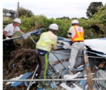
倒壊した車庫を解体・廃棄 (八街へ地区)
