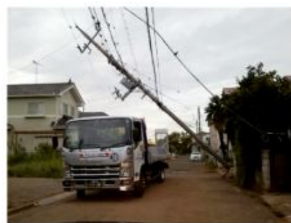
電柱倒壊による停電被害(大間地区)
